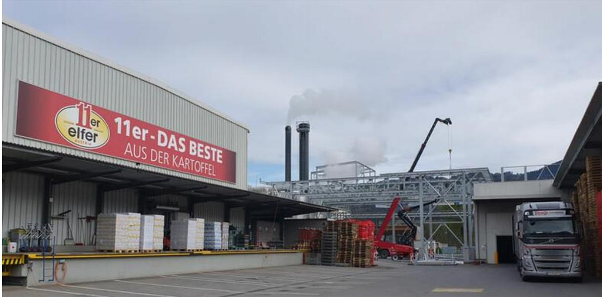
Auf dieser neuen Stahlkonstruktion werden die fünf Container für die Abluftreinigung platziert.
